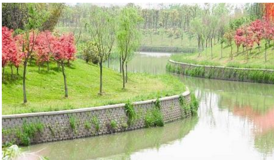
图 5-4 自嵌式植生挡土墙护岸实例
