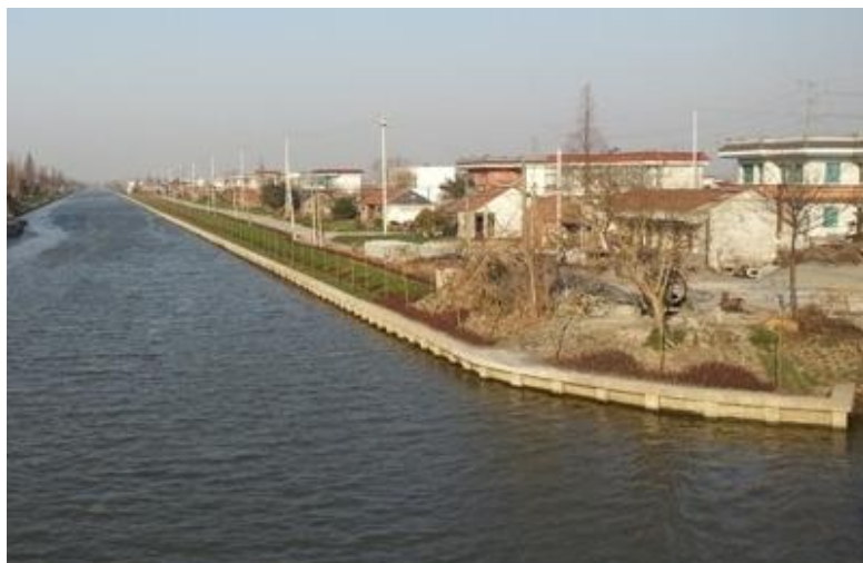
图 5-6 板桩护岸实例
