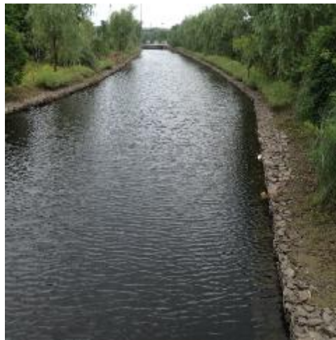
图 5-2 生态石笼护岸实例
